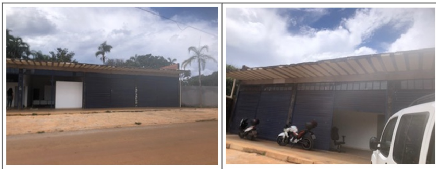
Figura 1 – Frente do imóvel
